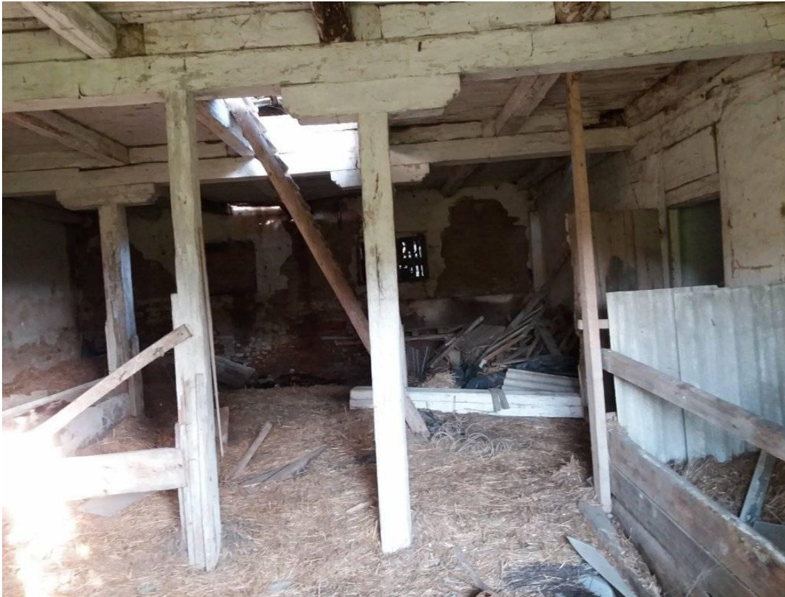
Фото 3. Всередині конюшні. Нині приміщення не використовується
