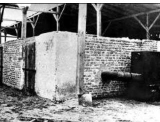
Майданек. Задня частина газової камери з «газогенераторною установкою».
