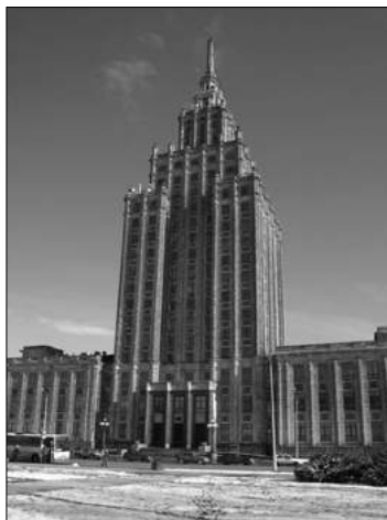
Латвія. Будинок Латвійської академії наук в м. Рига. Архітектори О. Тілманіс, В. Олтаржевський. 1951—1957.
