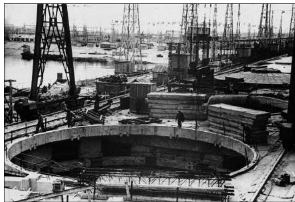
Будівництво Кременчуцької ГЕС. 1960.
