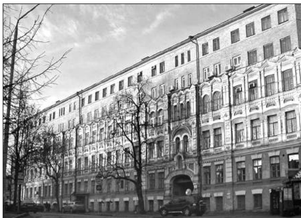
Колишній Михайлівський готель. 1907. Фото початку 21 ст. Чітко видно два добудовані пізніше поверхи.
