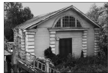
Шосткинський казенний пороховий завод. Будівля вододіючої порохової фабрики. 18 ст. Фото 2010.
