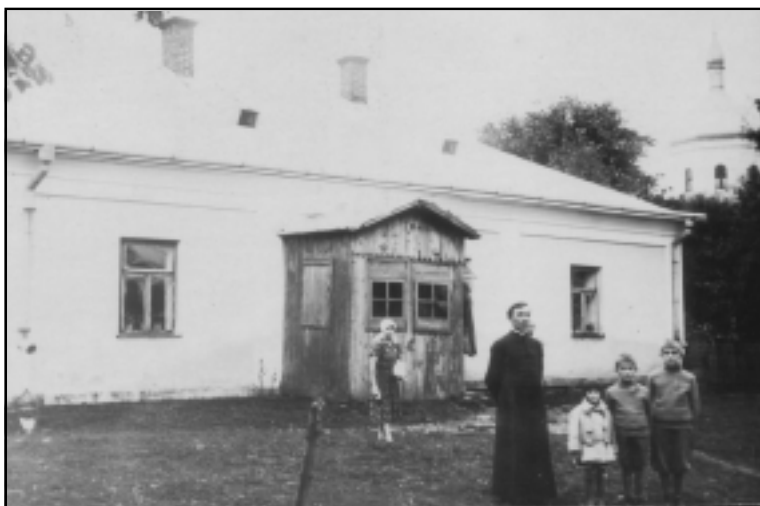
Приходство в Сорочі. Отець Микола з дітьми Лідією, Дометієм і Маркіяном
