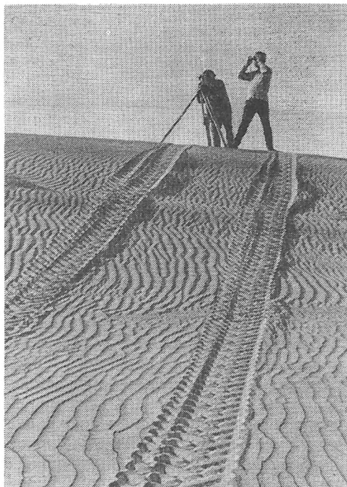
Розвідувальна партія Всесоюзного інституту по проектуванню газопроводів та підприємств газової промисловості «Гіпрогаз», що базується у Києві, визначає трасу для будівництва газопроводу Середня Азія — Центр у пустелі Каракуми. 1965 р.
