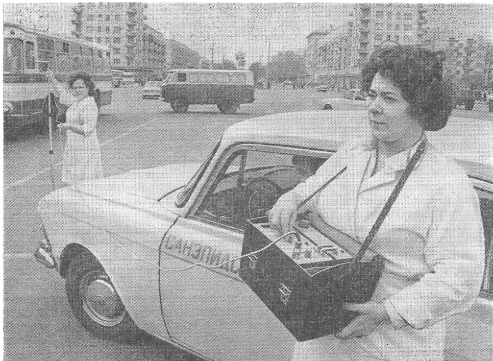
Замірювання рівня шуму на площі Перемоги співробітниками санітарно-гігієнічної лабораторії міської санепідемстанції. 1975 р.
