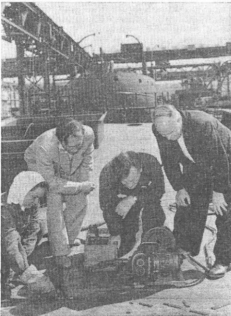
Випробування на судноверфі заводу «Ленінська кузня» нового напівавтомата для електрозварювання, створеного в Інституті електрозварювання ім. Є. О. Патона АН УРСР. 1956 р.
