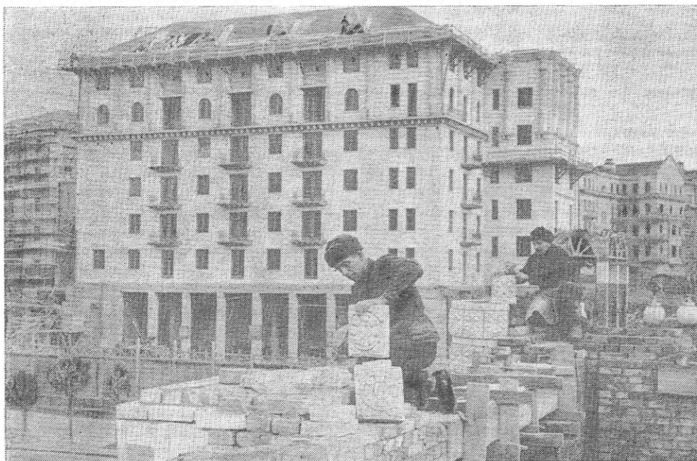
Будівництво житлових будинків на Хрещатику. 1950 р.
