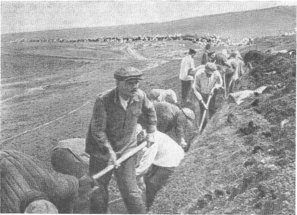
Будівництво оборонних споруд під Києвом. Липень 1941 р.
