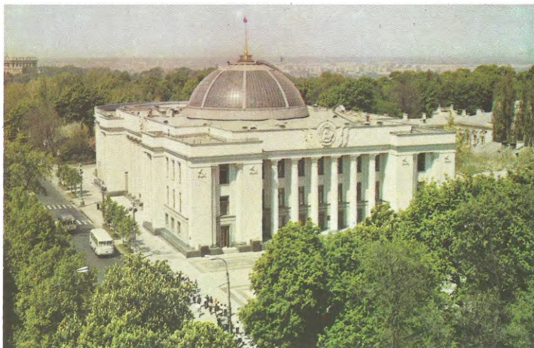
Будинок Верховної Ради УРСР. Архітектор В. Г. Заболотний. 1939 р.
