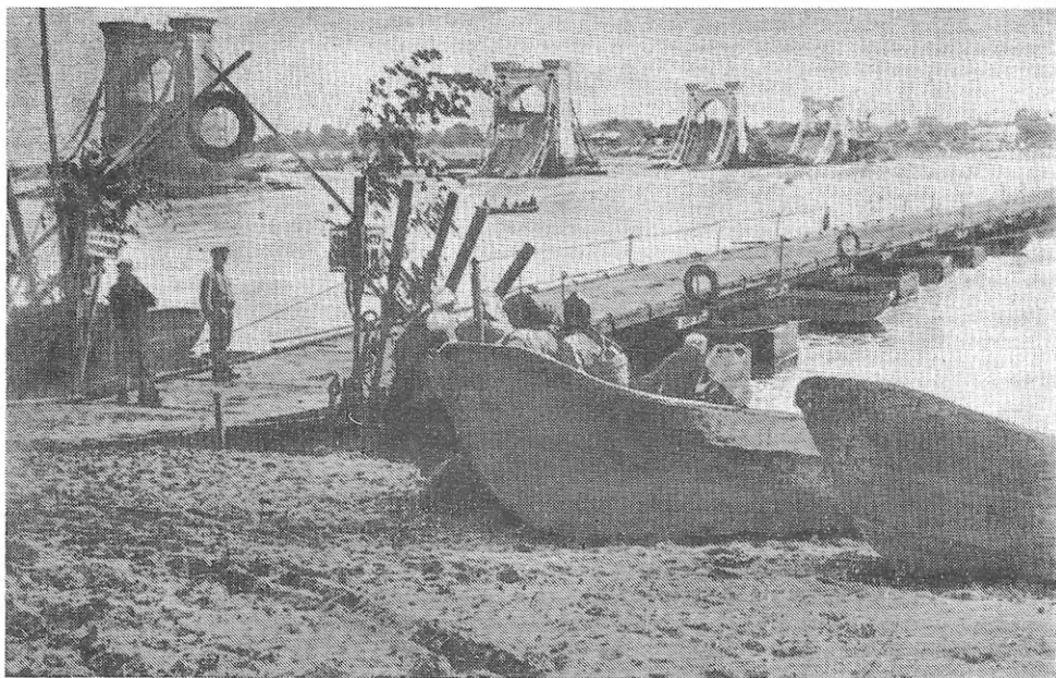
Ланцюговий міст через Дніпро, зруйнований білополяками під час відступу з Києва. Поряд — паплавний дерев'яний міст, збудований червоноармійцями після вигнання білополяків. 1920 р.
