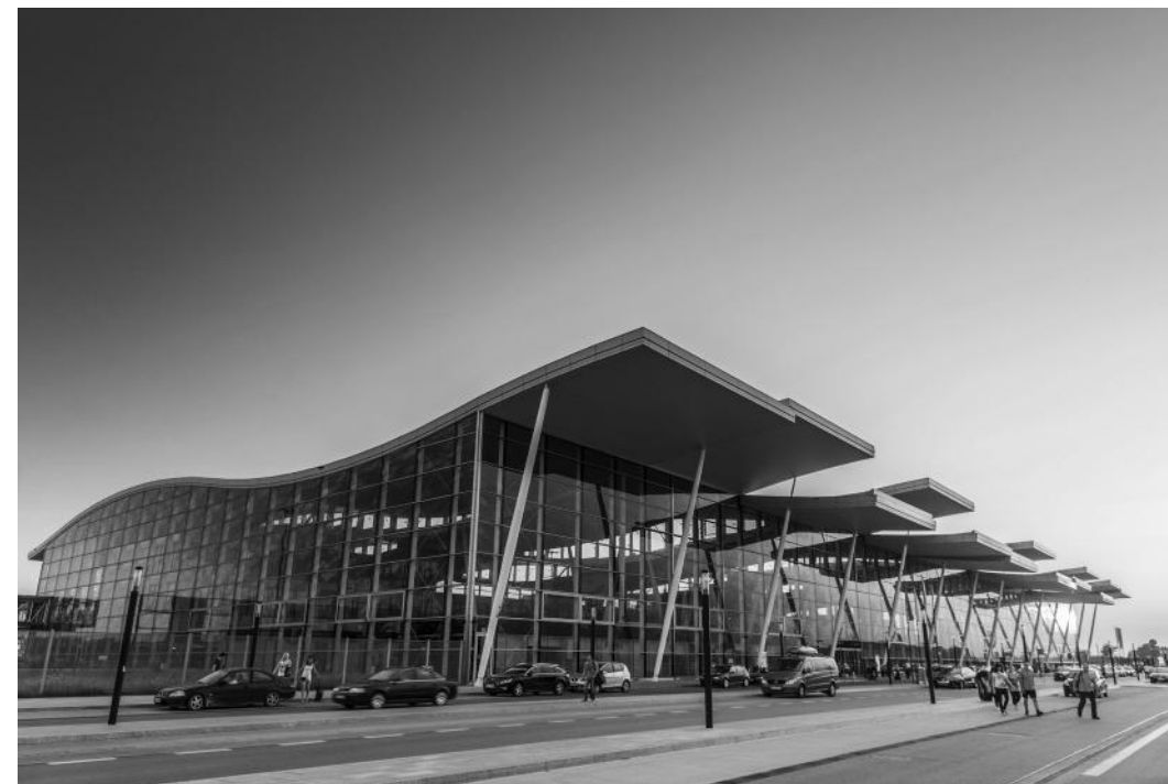
Новий термінал аеропорту Wrocław, JSK Architekci
