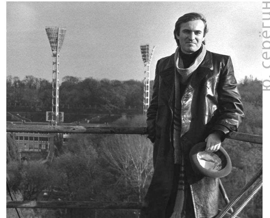
Серёгин на строительстве стадиона "Динамо" в Киеве, 1978
