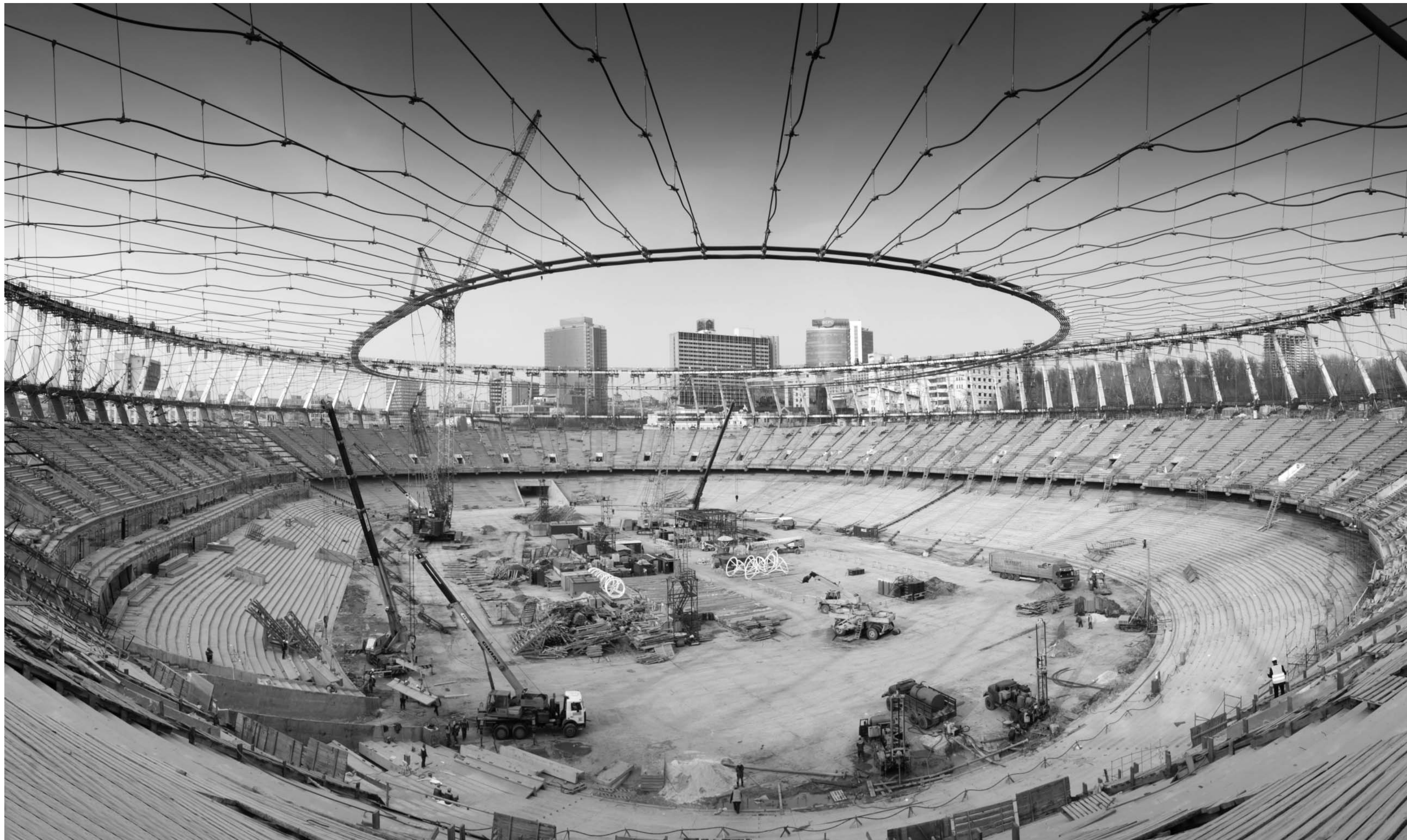
Монтаж вантовой конструкции, апрель 2011
