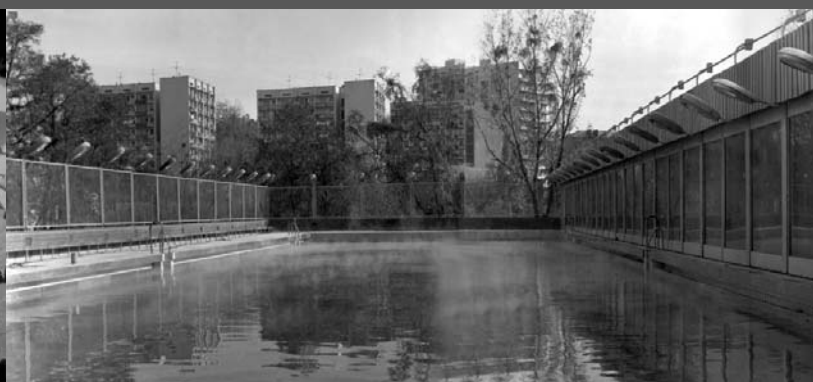
1970-1972 Плавательный бассейн на ул. Бастионная
