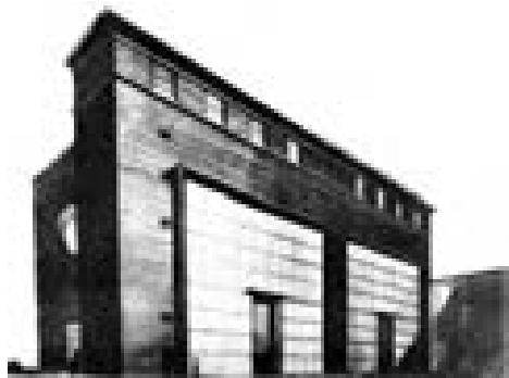
Электростанция на Рыбальском острове. Архитт. М. П. Парусников, Г. П. Гольц, 1930
