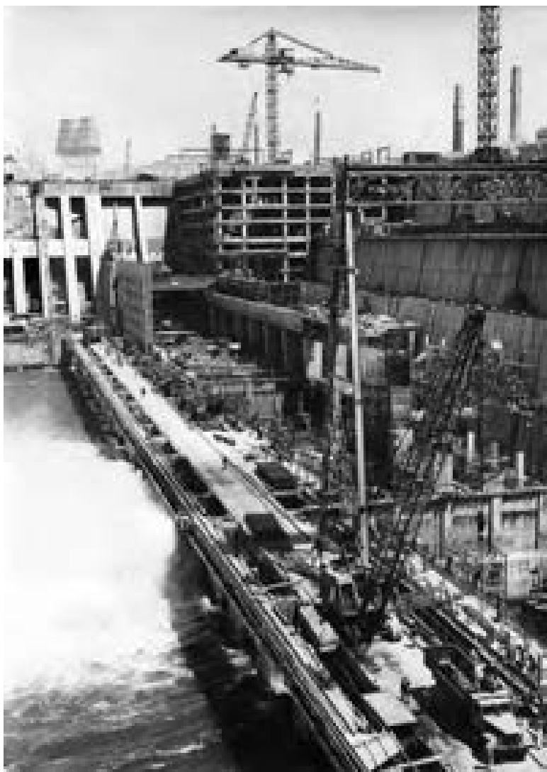
Строительство высотной Асуанской ГЭС, 1964–1968
