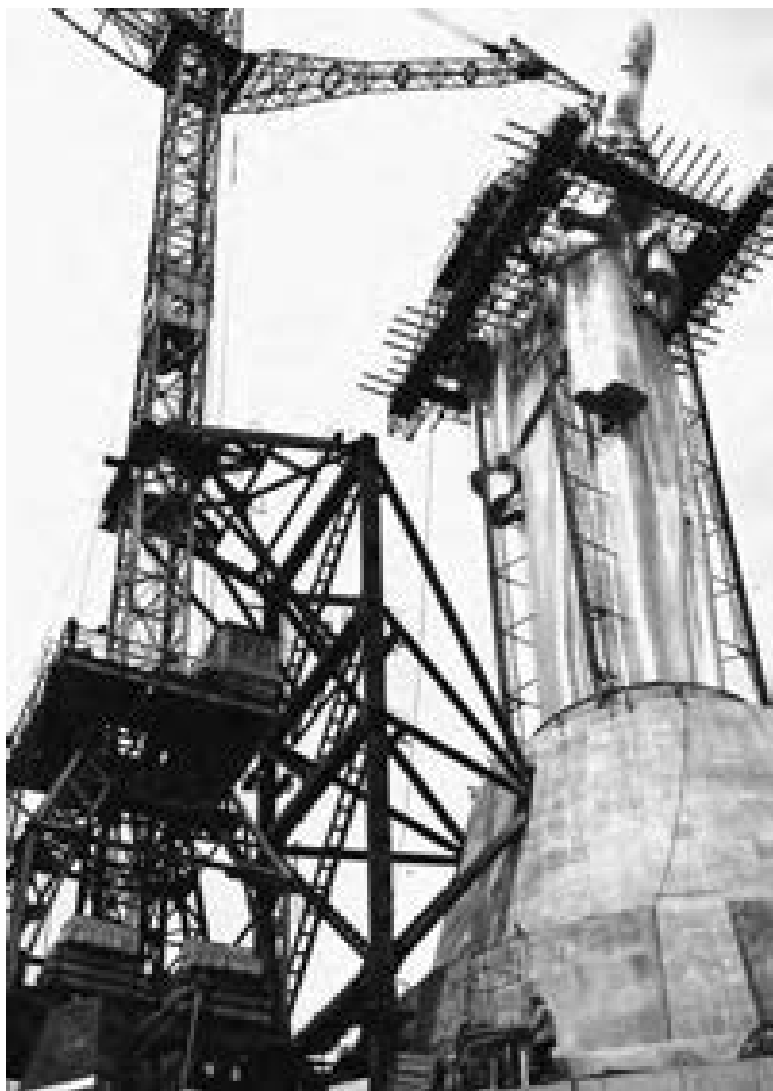
Монтажные конструкции и подвижный «выставляющий контур», 1980
