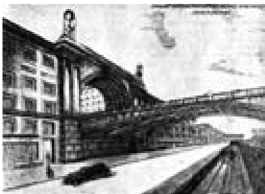
Правительственный центр, вид в сторону Св. Софии (вверху) и мост через ул. Жертв Революции на ул. Челюскинцев (в перспективе — Площадь), 1938
