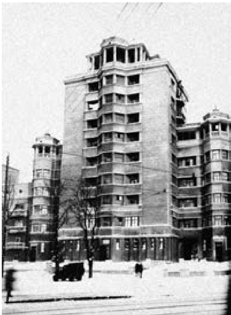
Жилой комплекс по ул. Январского восстания № 3. Архитектор И. Ю. Каракис, 1933–1937
