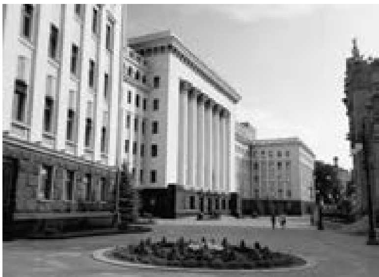
Здание штаба КОВО. Архитектор С. В. Григорьев, 1936–1939
