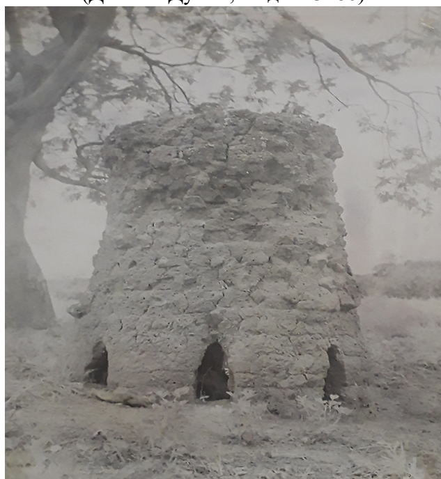
Рис. 3. «Старовинна домна до випалення заліза з лятеритної глини майстрами «Нуму» (ДІКЗ м. Дубно, Н. доп. 3286).
