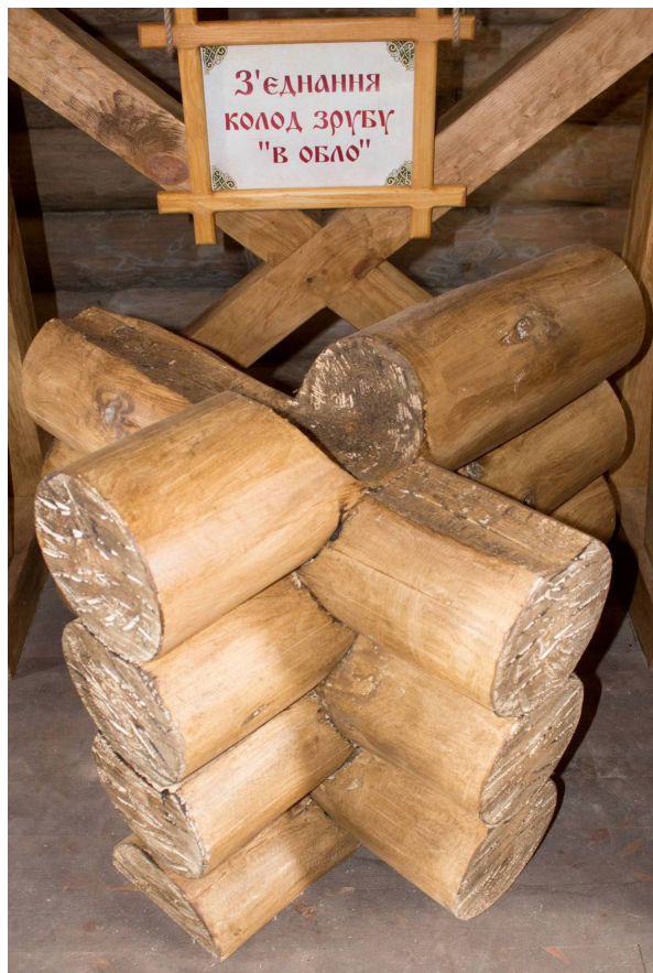
Рис. 25. Макет конструкції зрубів. Метод врубки «в обло». Музей зодчества ПКР
