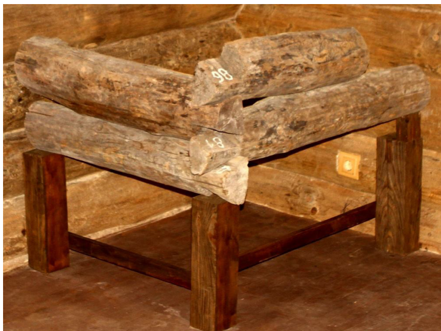
Рис. 20. Напівколади з конструкції криниці XIX ст. вул. Введенська, 35 у 2005 р. Музей зодчества ПКР
