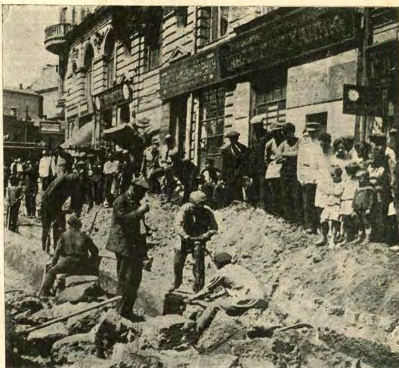
Харків ремонтується. Механізовані роботи по переводу трамвая на широку колію
