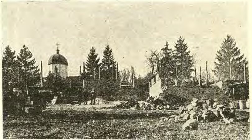
Виведено фундамент лікарні
