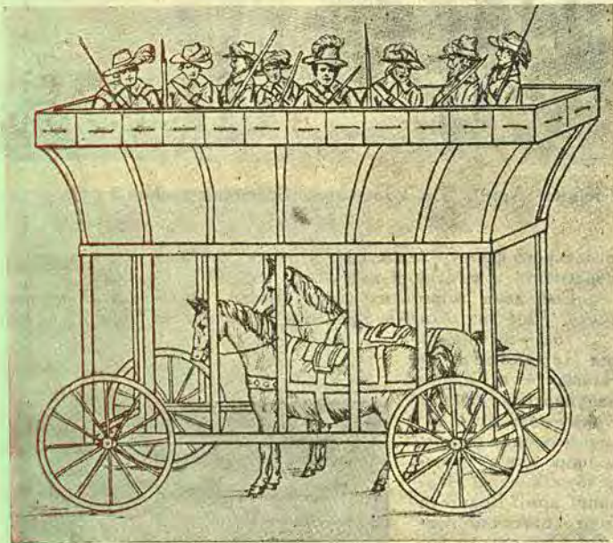
Мал. 2. Шотландський військовий віз другої половини XV віку. Рухачька сила—сховані всередині коні. Вгорі містяться вояки і дві легких гармати
