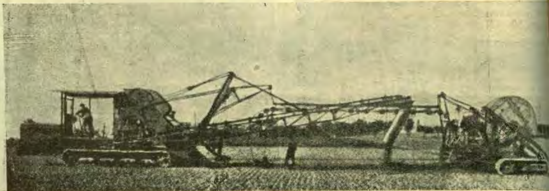
Машина Шрамма для прокладання кабеля. Спереду трактор, ззаду платформа з кабельним барабаном. Гусельні ходи дозволяють машині не зважати на нерівності ґрунту
