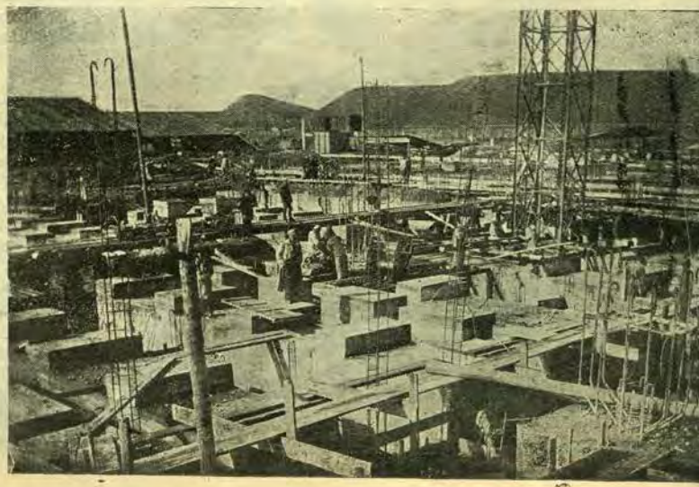
Вежа для заливки бетону. Вгорі—проект електростанції. Праворуч—кладуть фундамент
