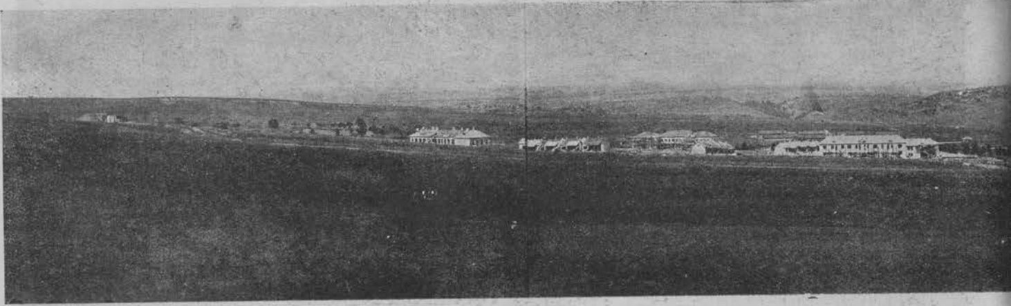
Загальний вигляд робіт
