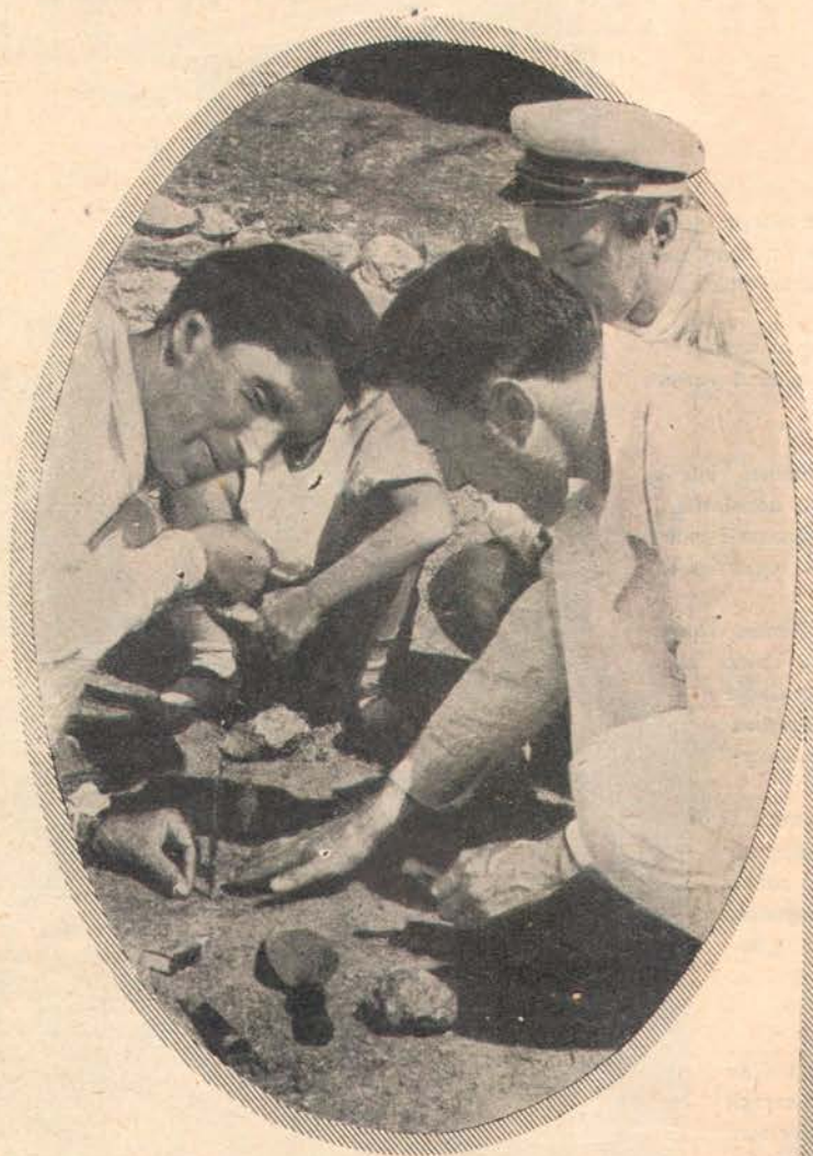
Підчас землетрусу в Криму студенти, що були тут на відпочинку, влаштували примітивну сейсмографічну станцію. Апаратура цієї „станції“ надзвичайно проста, зроблена з річей, що попали під руки—ручка з пером, закінчена пробірка. Студенти вартували на „станції“ 2 доби по 2 години кожний і відмітили 27 підземних ударів. На фотографії—спостереження за працею сейсмографа
