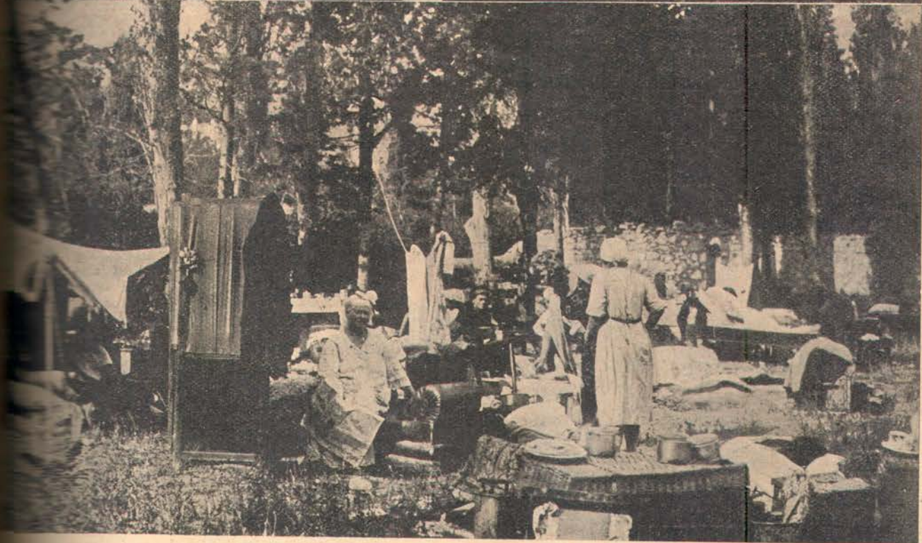
Землетрус у Криму. Вгорі — зруйнований землетрусом будинок у Ялті. Нижче — санаторій в садку
