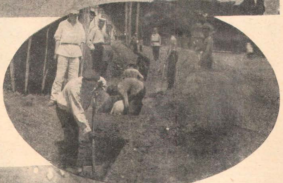
Проводять водопотяг у Сорочинцях
