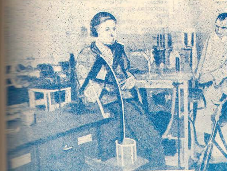
Визначення витрати сили при роботі рукою — робітниця вимірює вагу, контрольний прилад розструє зроблену роботу і кількість спожитого повітря
