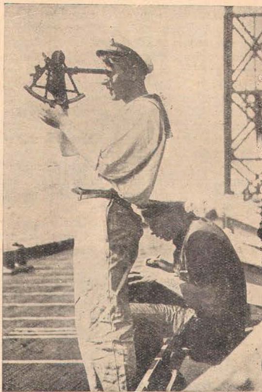
Під час походу учні вищої морської школи знаходять секстантом місце перебування судна
