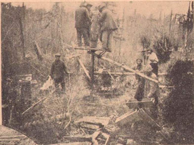
Розвідка в глухій тайзі. Свердлять землю.
