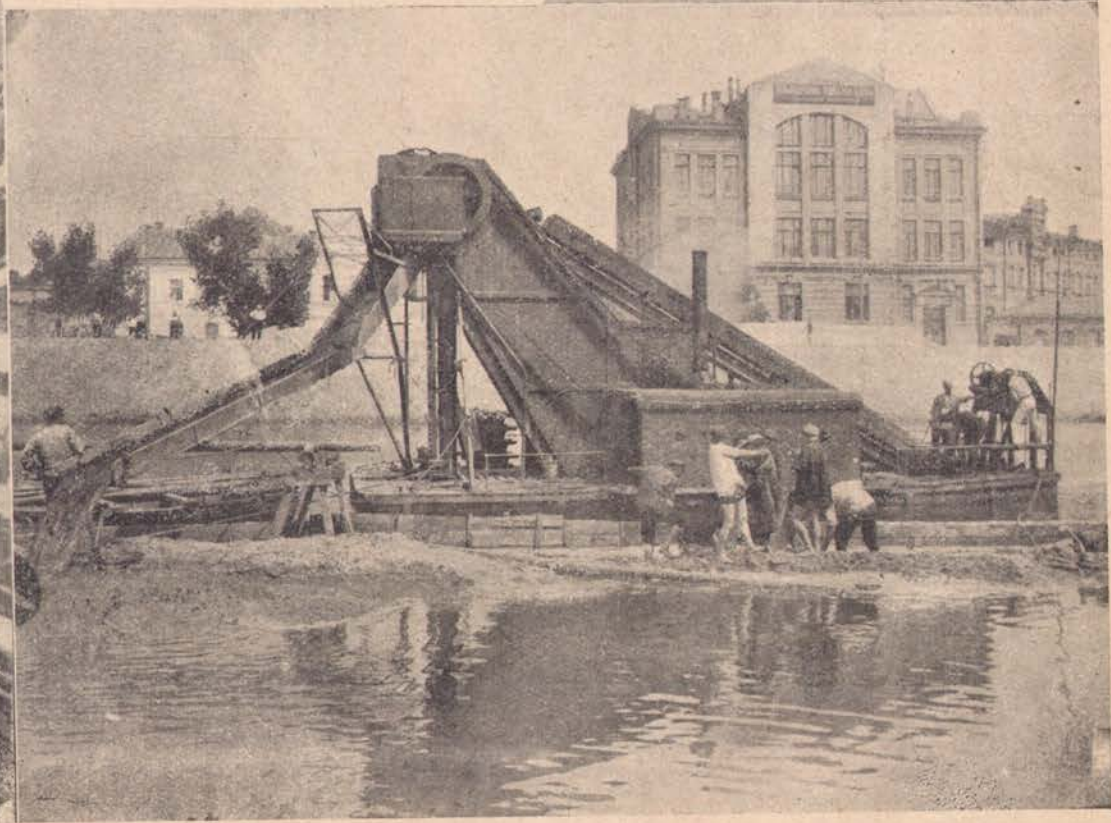
Угорі—загальний вигляд на будівлю трестівського будинку. По боках—окремі моменти будівельної роботи. Внизу—робота на р. Лопані. Землечерпалка. Ріку очищають від намулу й поглиблюють
