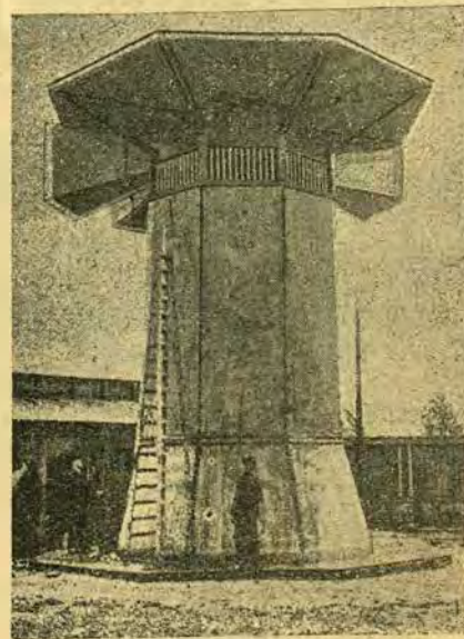
РАДИО-ВИСТАВКА В БЕРЛІНІ. Гучномовець Сіменса з полотняними стінками.
