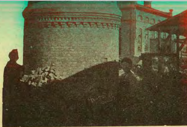
На заводі імени Шмідта будується нова труба.
