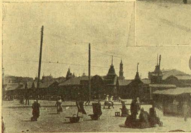
Благбаз. Нові будівлі.
