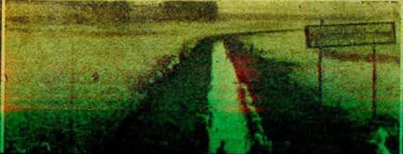
тегорії: вузенькі канали 3-го ступінія, що осушають ґрунт, забираючи йому лишню воду, канали 2-го ступіня, або стрілки вже ширші, що цю воду збирають і проводять до головних каналів і канали 3-го ступінія, або головні канали, іноді до 3-х сажнів, або і більше завширшки, що всю воду з болота відводять до річок, або озер.
