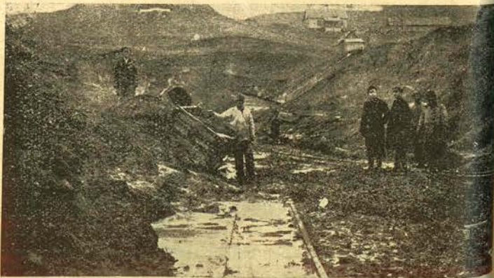
Вода заважає роботі—змито рейку, перекинута вагонет
