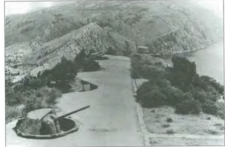
80-та окрема берегова 130-мм батарея. Балаклавська бухта. 1970 р. Встановлено в 1951 р. після демонтажу 127-мм гармат „Бофорс”. До війни 1941 р. тут була 19-та берегова батарея 122-мм гармат. Світлина В.Смирнова. Знімок надає капітан I рангу Б.Новоселецький
