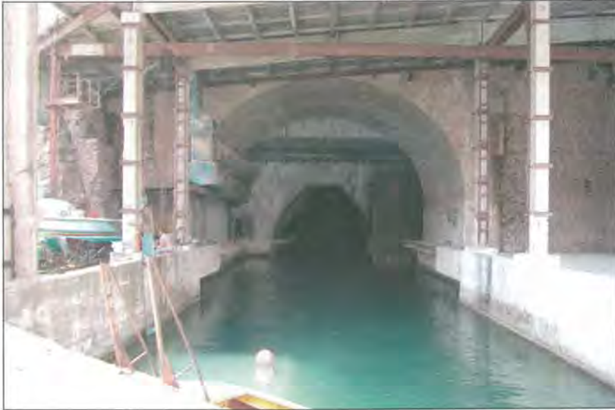
Вхід у штольнію з каналом
