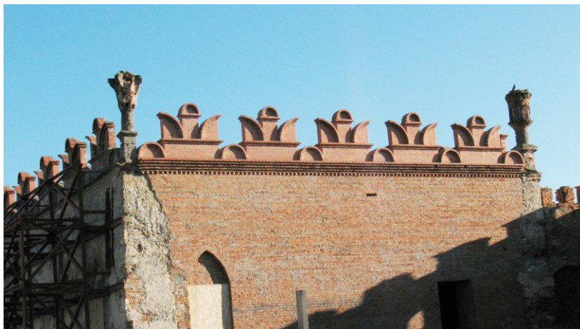
Рис. 18. Аттік палацу Сенявських в Меджибожі після реставрації зубчастого гребеня, 2018 рік
