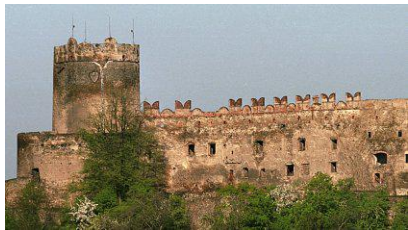
Рис. 4. Зразок ранньоренесансного аттика за М. Златом: два різновиди «півколистого» аттика замку в Болхуві (Нижня Сілезія). Будівничим вважається Якуб Парр (di Pario). Гладкий фриз, гребінь аттика як та вежі, так і на мурі утворено комбінаціями півкола та четвертини кола у поєднанні з прямокутниками. Фото Jerzy Strzelecki, Wikimedia Commons, CC BY 3.0
