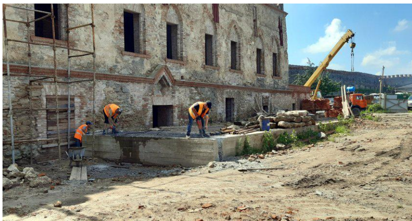
Рис. 2. Демонтаж опорної плити балочної металоконструкції, яка підтримувала північний фасад палацу впродовж 2015-2019 рр.
