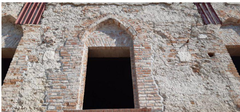
Рис. 5. Фрагмент фасаду палацу Сенявських з двома прямокутними опорами та слідами прилягання арочних склепінь галереї
