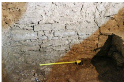
Рис. 8. Арочний отвір I 1 . Основа обкладки арочного отвору
