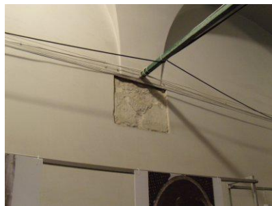
Рис. 7. Елемент опори склепіння кам'яниці Корнякта із зрубною декоративною частиною
