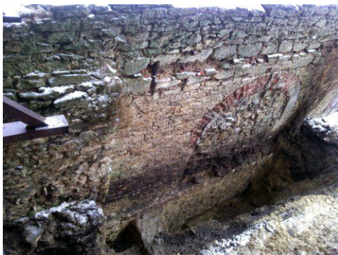
Рис. 2. Археологічне дослідження замкового мосту, грудень 2016 р. В шурфі нижче рівня поверхні видно муровані конструкції, на які поставлено міст.
