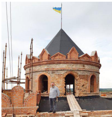
Рис. 32. Кругла вежа Меджибізького замку після реставрації зубчастого гребеня (2020 р.)
