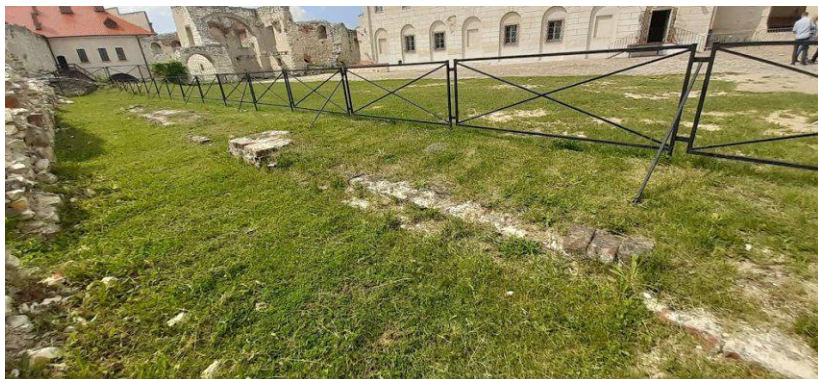
Рис. 13. Фундамент галереї у замку Фірлеїв в Яновці, Польща
