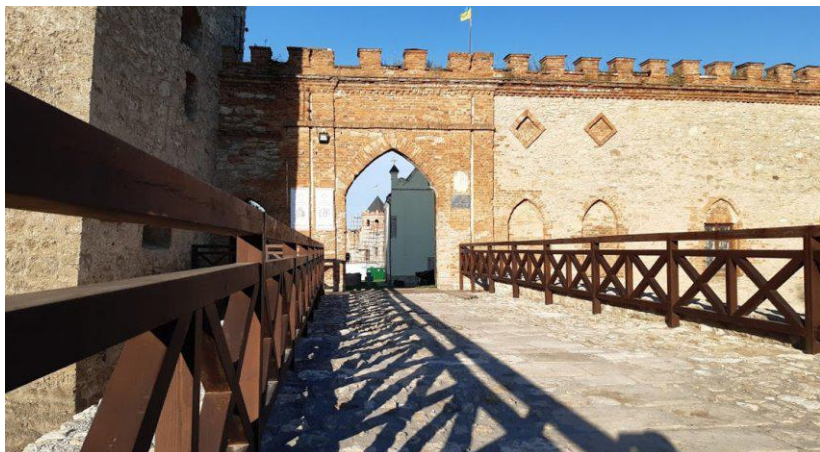
Рис. 4. Міст після виконання першої черги реставраційних робіт, 2020 р.
