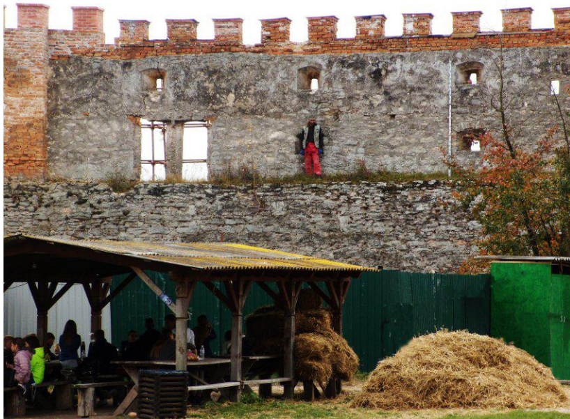
Рис. 4. Частина Південного муру, вигляд з подвір'я фортеці. Видно різницю між висотою муру до і після надбудови, зубчастий аттик та подвійний проєм настінного туалету. Мірало: фігура людини та 3-метрова нівелірна рейка
