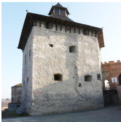
Рис. 1. «Лицарська» вежа, загальний вигляд
