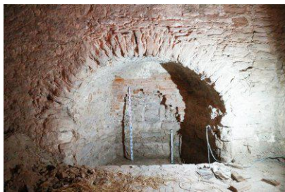
Рис. 10. Арочний отвір 4 1 після часткової розчистки швів
