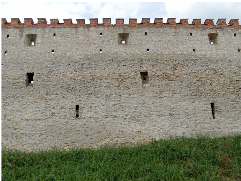
Рис. 2. Частина Південного муру з бійницями різних типів. Вигляд ззовні фортеці
