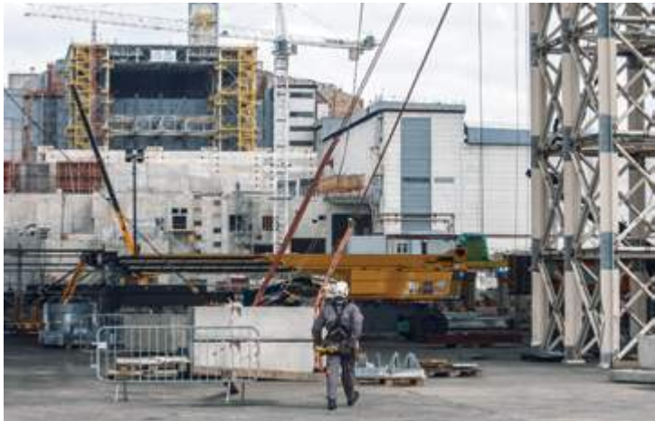
Завершення робіт. Інженери запевняють, що арку над саркофагом можна буде ставити вже наступного року
