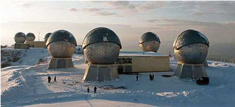
Рис. 2.136 – Оптико-електронний комплекс “Окно”
