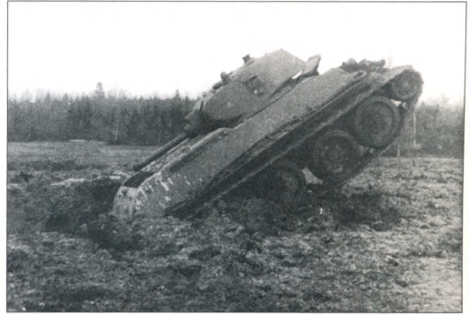
Випробування танка на полігоні: Т-34 вибирається з воронки
