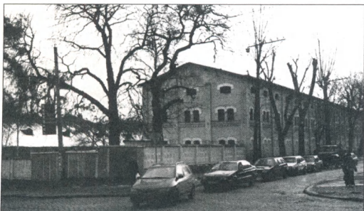
Складські приміщення на розі вулиць Шевченка та Ярослава Мудрого
