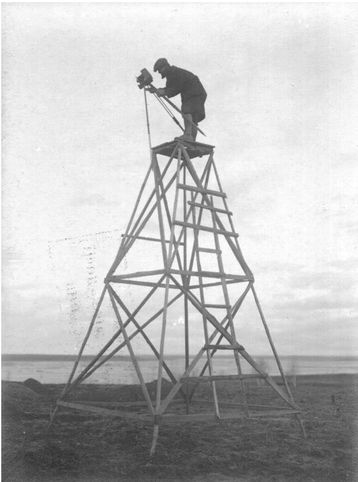
Рис. 24. Пушкарі І. Вишка для ортогональної зйомки. 1933 р. [НА ІА НАНУ, Ф. 30. Спр. 356].
