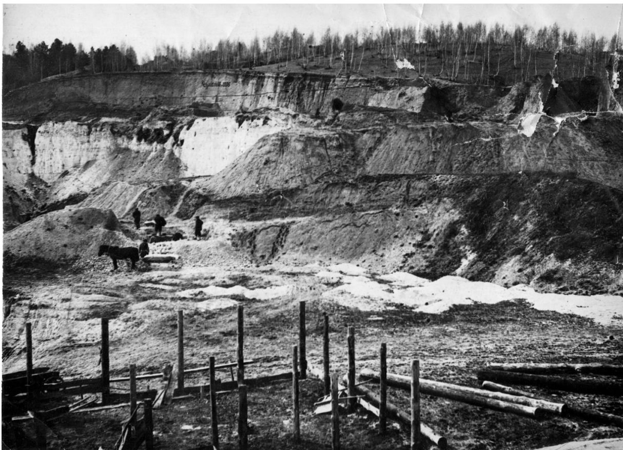
Рис. 32. Чулатів І. Загальний вид на кар'єр, де робились зачистки І.Г. Підоплічком. 1935 р. [НА ІА НАНУ, Ф. 57. Неупорядковане].
