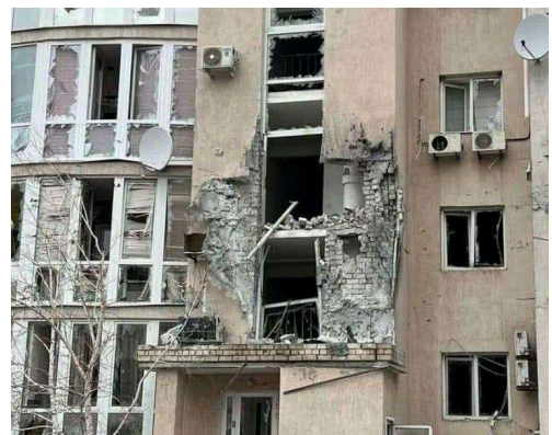
17.03.2022р. – Северодонецьк, це був елітарний будинок, с досить дорогими квартирами
