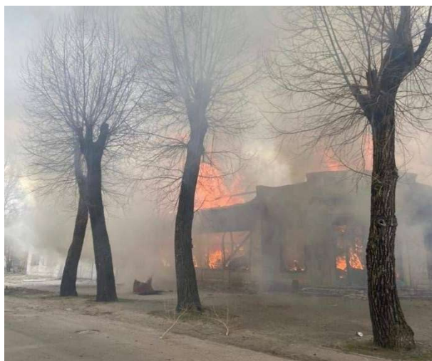
06.04.2022р. – Сєвєродонецьк, палає історична споруда - будівля магазину «Космос»
