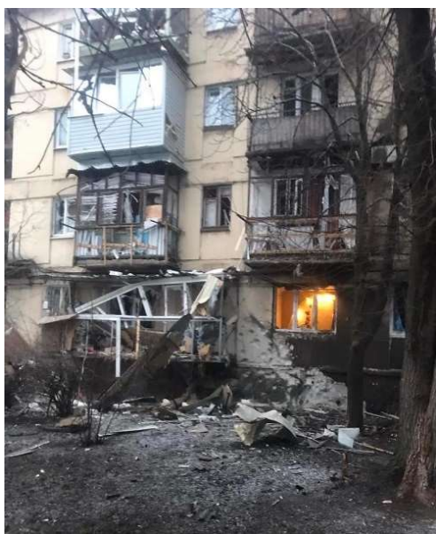
03.03.2022р. – Северодонецьк, руйнування житла
