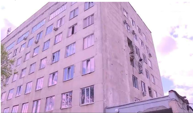
Северодонецьк, квітень, пошкодження будівлі хірургічного корпусу
