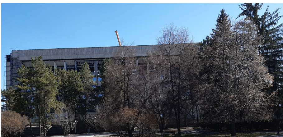
Західний павільйон акімату відновлюється після пожежи
