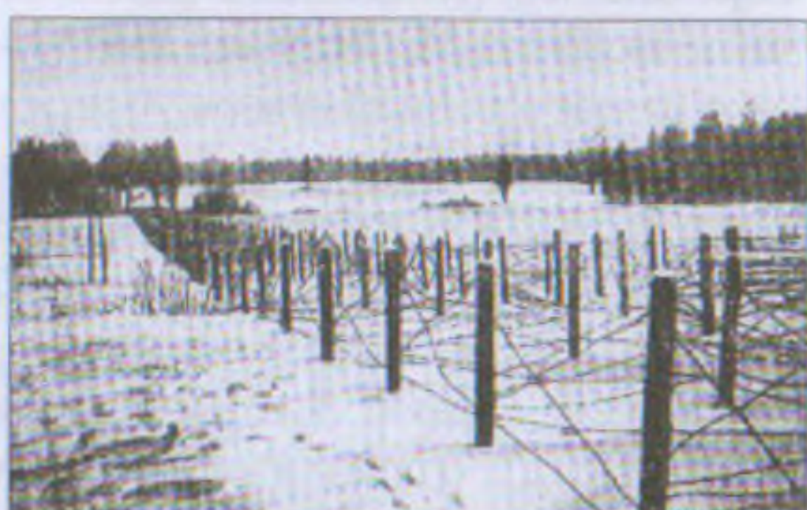
«Лінія Маннергейма». Протитанкові загородження (рови і надовби). Протипіхотні загородження (лісові та дротяні)
