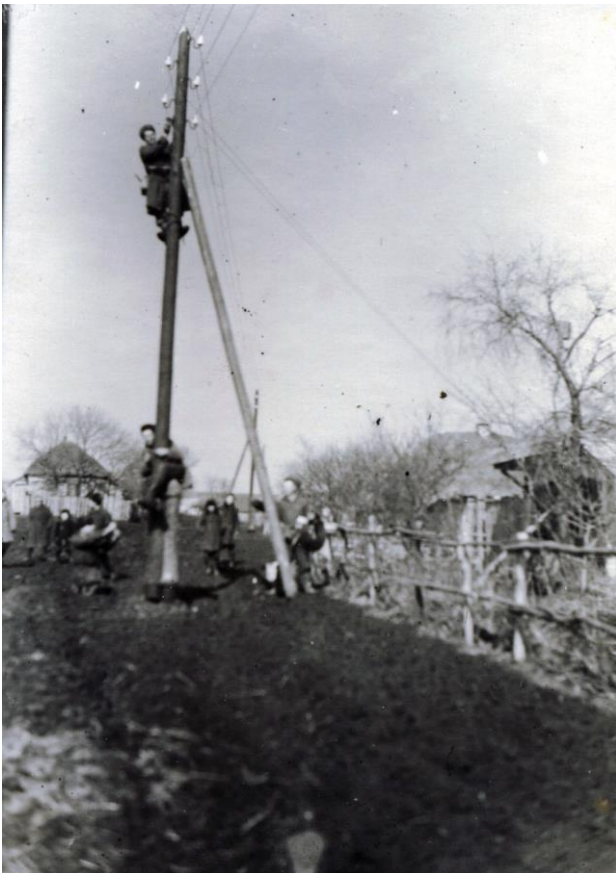
Ф.26. Проведення електрики
