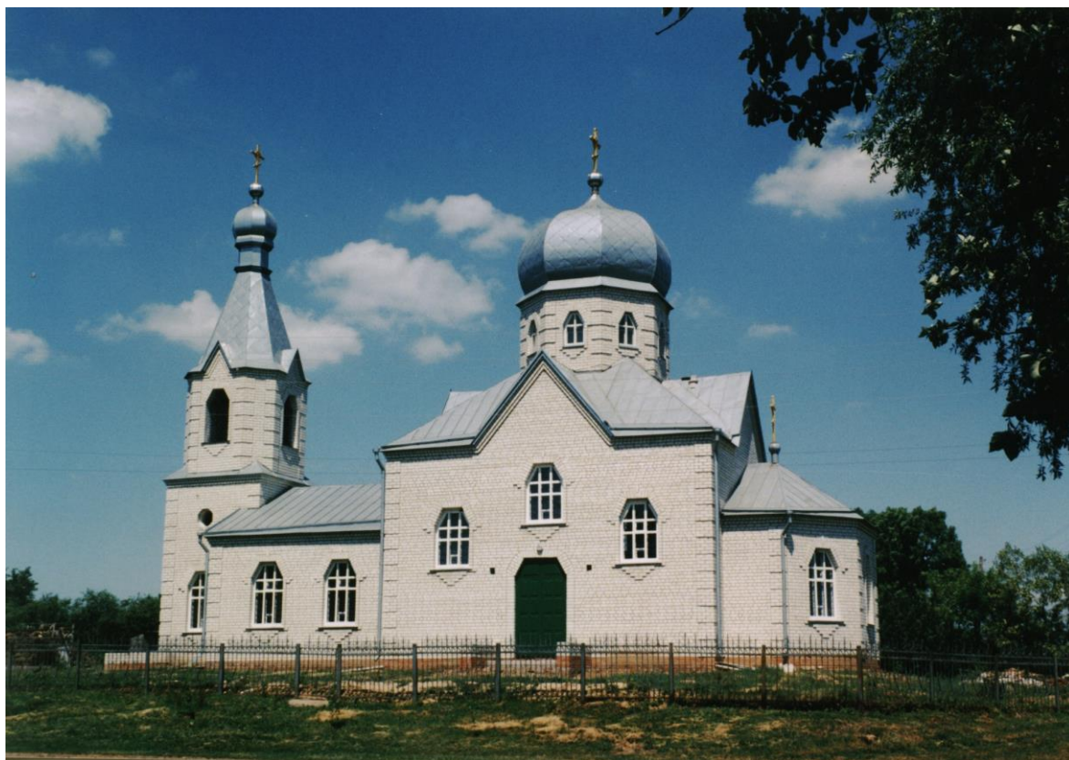
Нова кам'яна церква, збудована на фундаменті старої, дерев'яної
