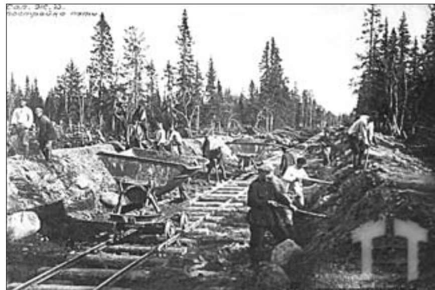
Прокладання залізниці на Соловках. Кінець 1920 рр.
