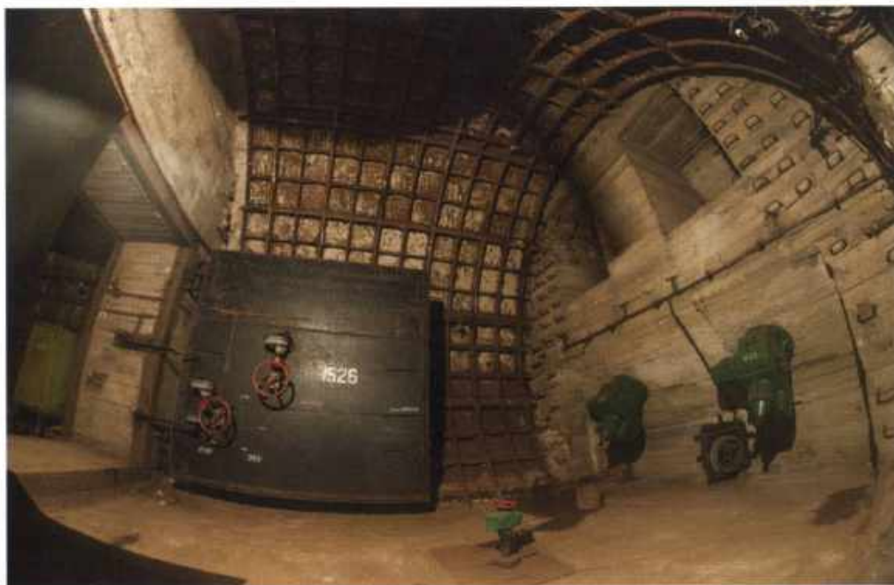
Гермоворота на ССВ — соединительную ветвь между тремя линиями Киевского метрополитена. 📍 «Кловская»
