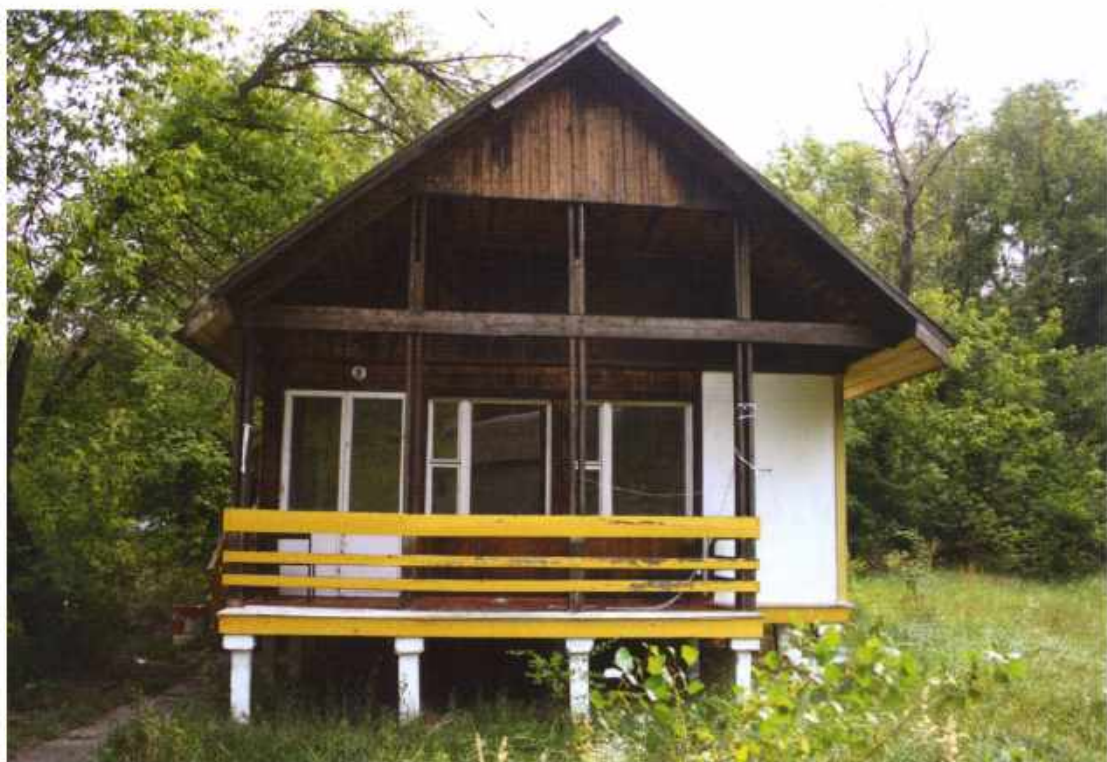
Жилой домик в пионерлагере «Ленинец», ул. Трухановская, «Почтовая площадь»
