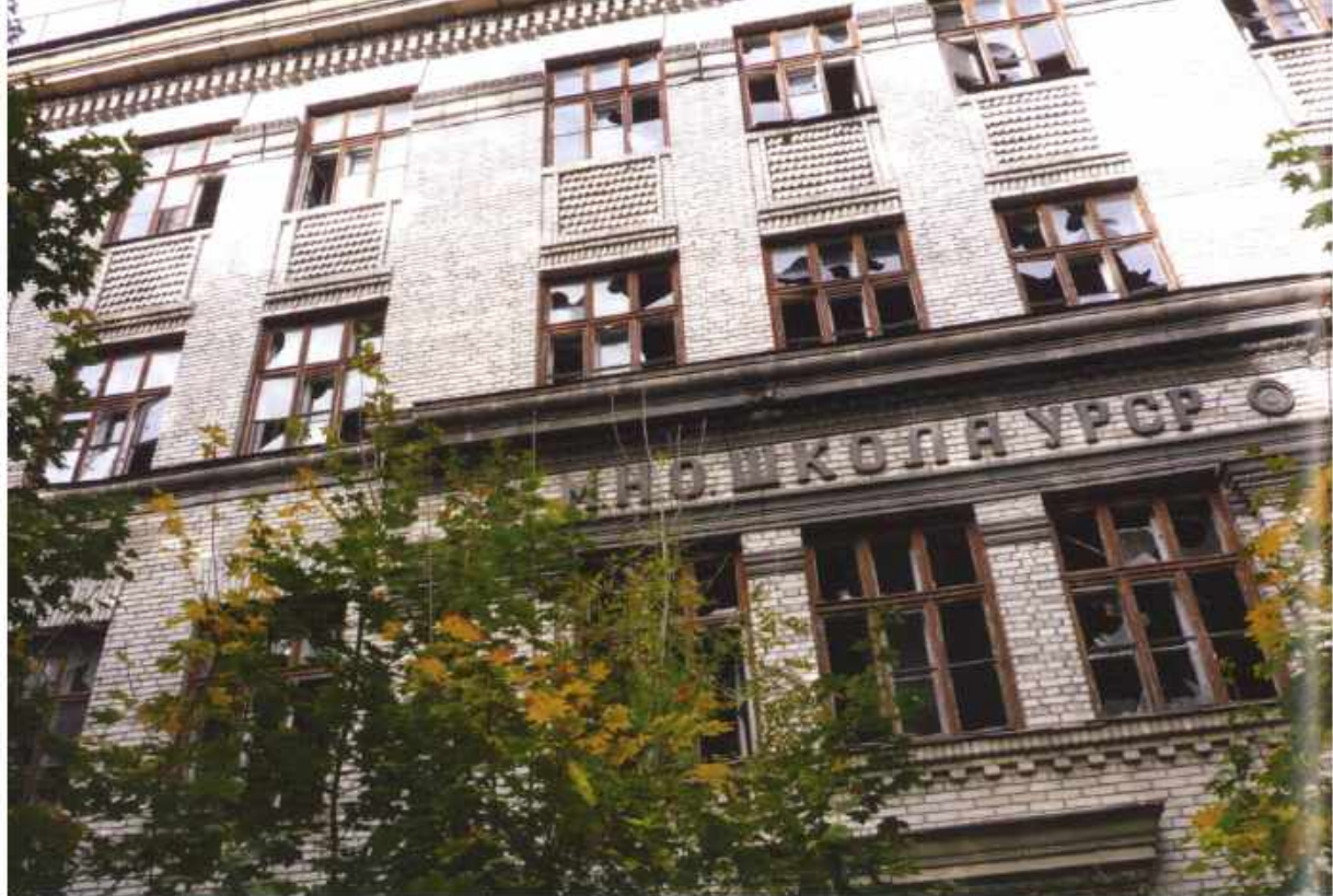
Заброшенная школа на Пост-Волыньском
