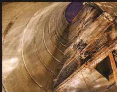
Один из бункеров дренажной системы неподалеку от Аскольдовой могилы, давшей имя подземелью
