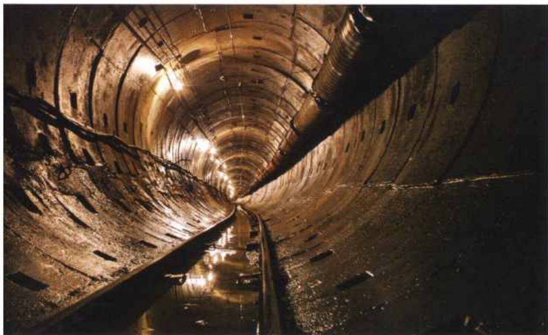
Строящийся участок ГКК, «Олимпийская»
