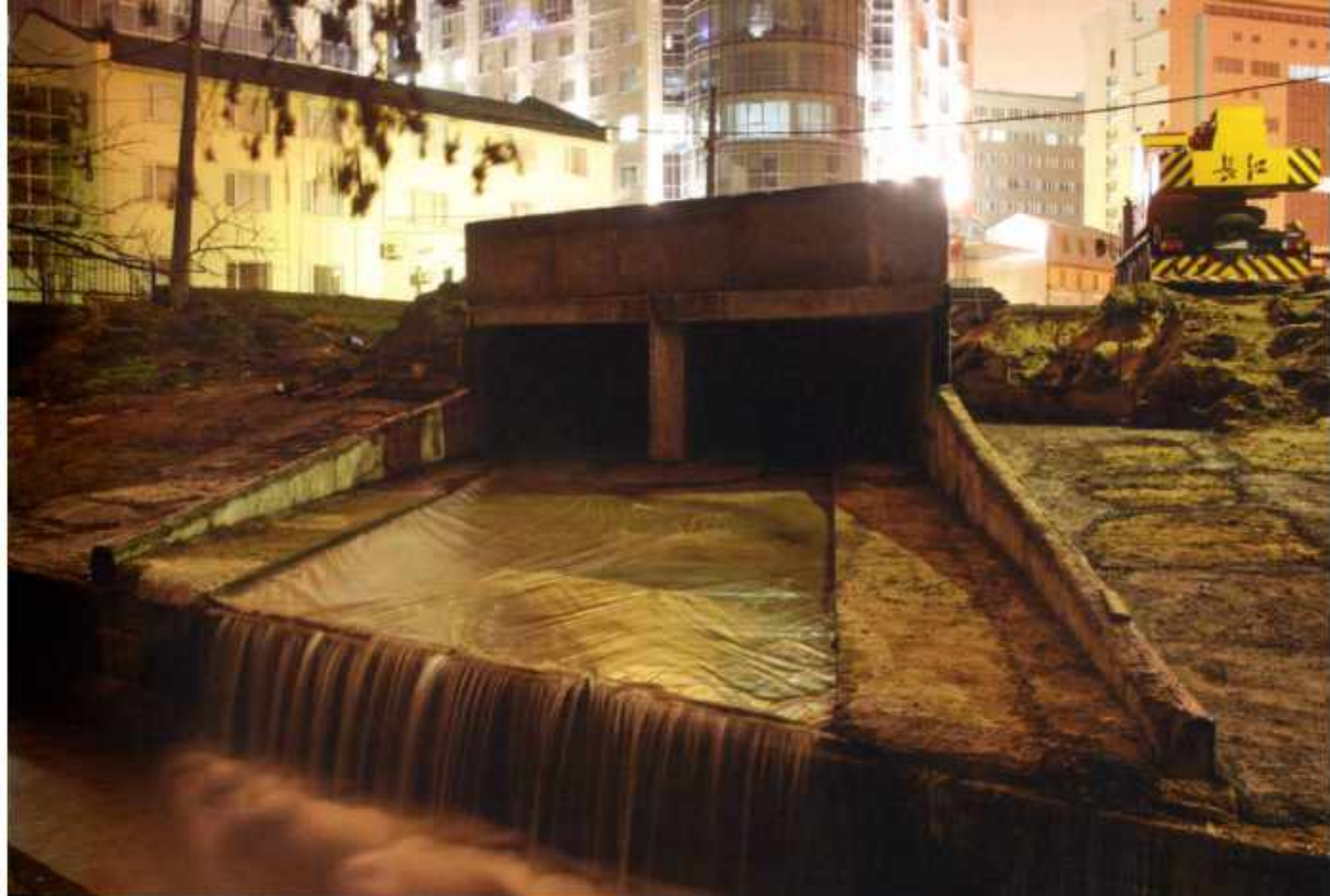
Устьевая часть подземной реки Клов
