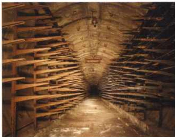
Вентиляционный канал, соединяющий «Консерву» с рабочими тоннелями
