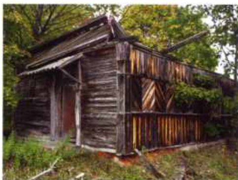
с. Ковшиловка практически полностью разобрано мародерами. 30 сентября 2012 года
