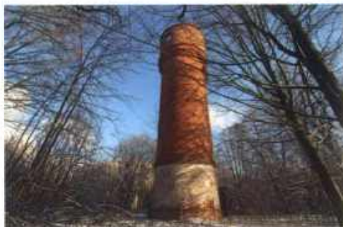
Водонапорная башня в пгт Полесское
