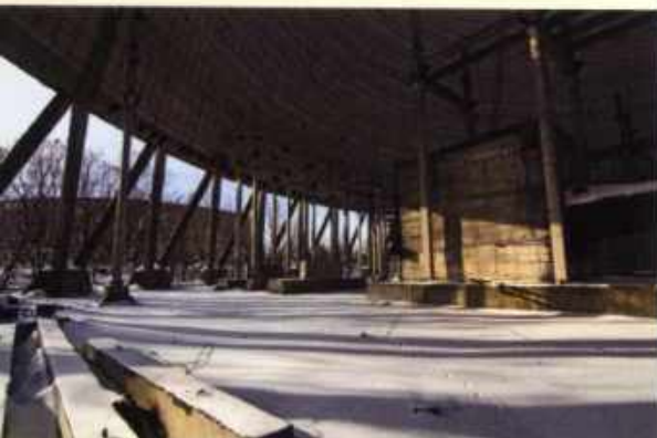
Основание недостроенной градирни третьей очереди
