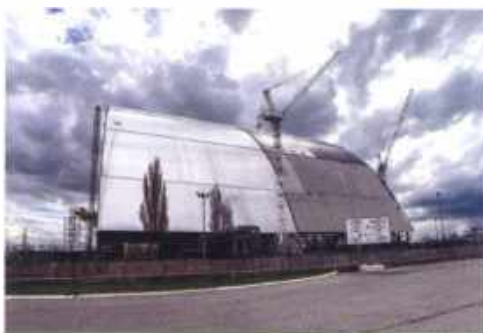
Объект “Укрытие-2” или “Арка”
