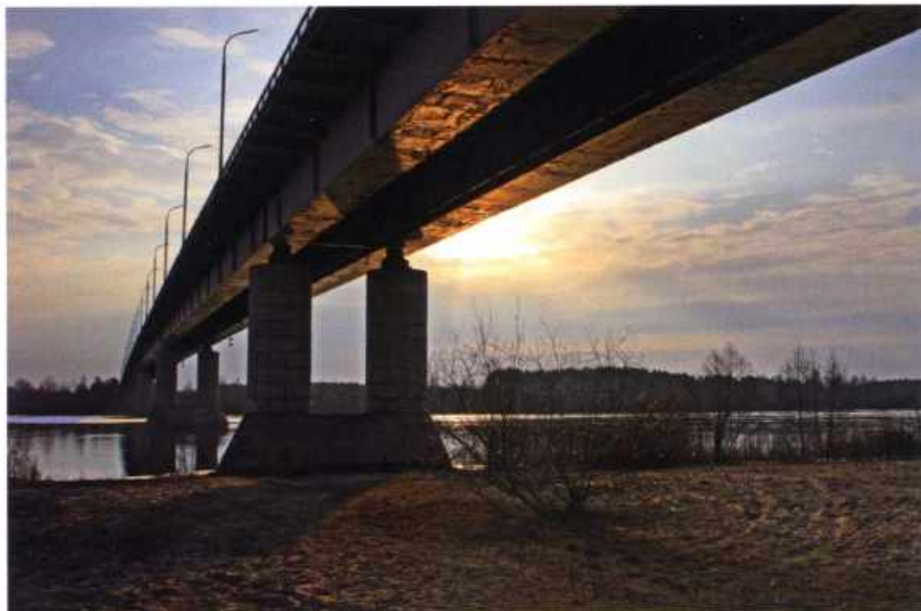
Автомобильный мост через реку Припять. 19 января 2014 года
