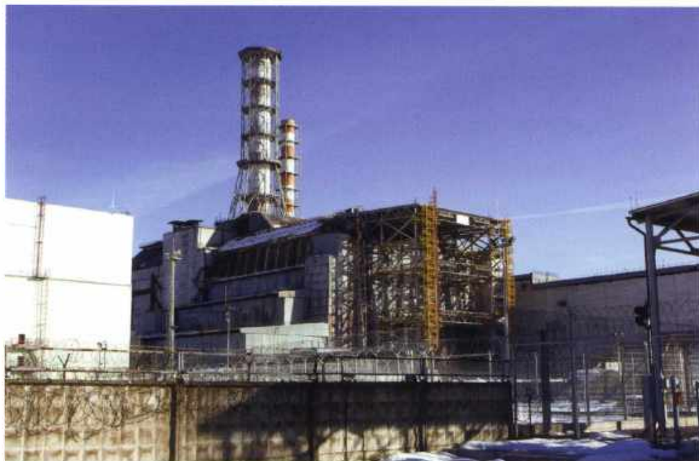
В 2012 году над саркофагом возвышались сразу две вентиляционных трубы — новая и старая. Впоследствии старую, загрязнённую радиацией трубу срезали
