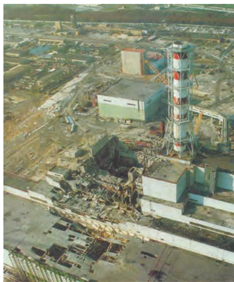
↑ Зруйнований четвертий реактор ЧАЕС
