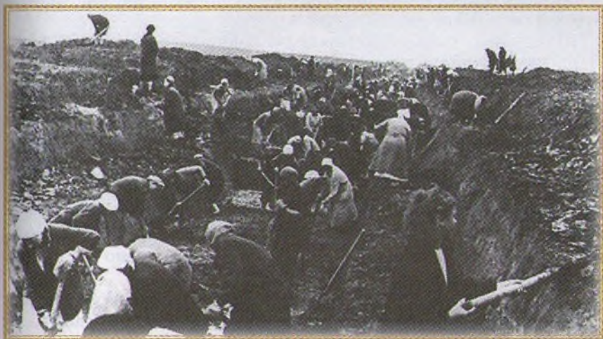
Робота над будівництвом оборонних споруд
