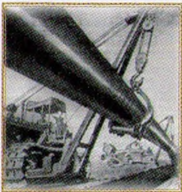
Прокладка газопроводу. 1949 р.
