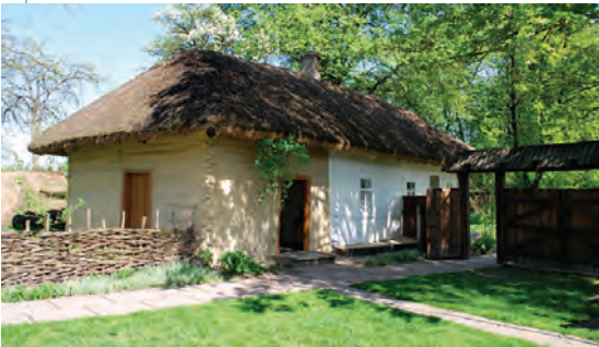
▲ Будинок у селищі Сосниця Чернігівської обл., де народився і виріс Олександр Довженко. Із 1960 р. – літературно-меморіальний музей митця
