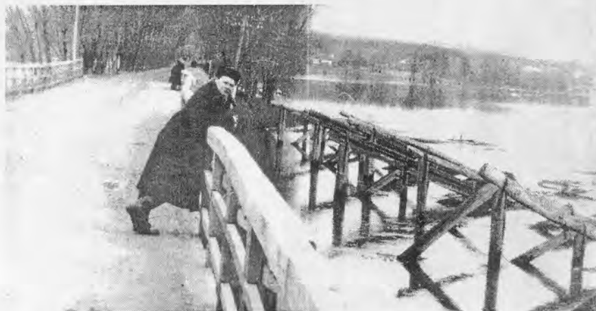
Дерев'яний міст через річку Сула
