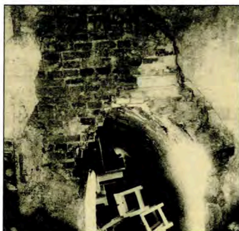
Стіна зі слідом стесаного склепіння. Зондаж 1957 р.
