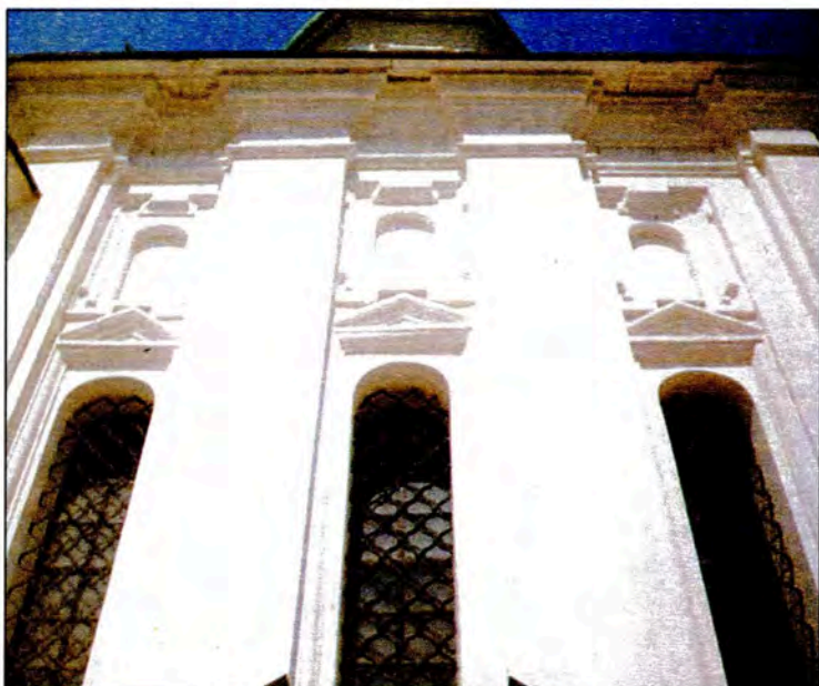
Церква Преп. Феодосія Печерського. Південний фасад. Фрагмент. Вікна та ніші. Фото автора. 2002 р.
