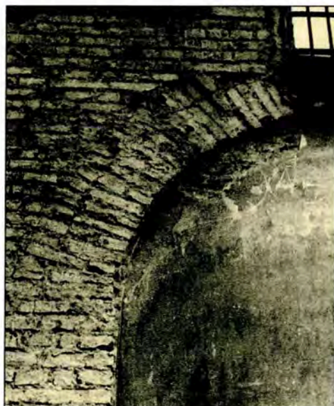
Західний фасад колишньої келії квасоварів. Зондажем відкрита цегляна кладка арки. 1957 р.
