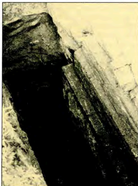
Західний фасад. Фундамент під келіями квасоварів. Шурф. 1957 р.
