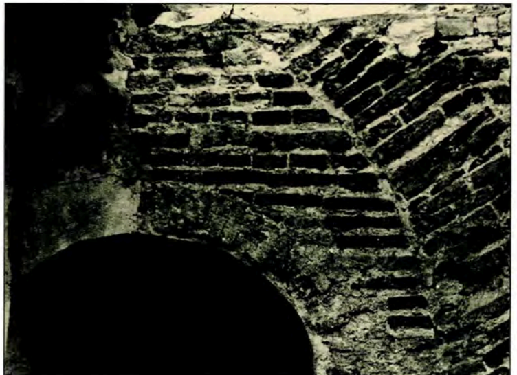
Микільсько-лікарняна церква. Внутрішня стіна північного фасаду зліва від входу зі слідами розпалубки склепіння. Фото 1954 р.
