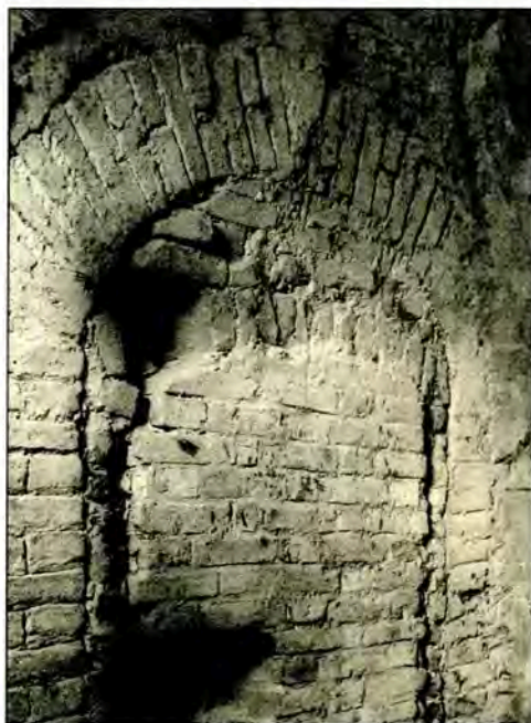
Замурування дверного отвору в стіні келії квасоварів. XVII ст. Зондаж. 1957 р.
