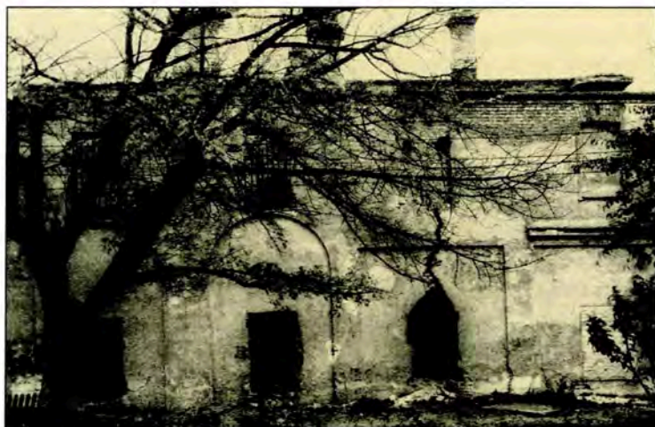
Келія квасоварів. XVII ст. Західний фасад корпусу № 1 за сучасною нумерацією, до складу якої входила келія квасоварів XVII ст. Західний фасад до реставрації. Фото 1957 р.
