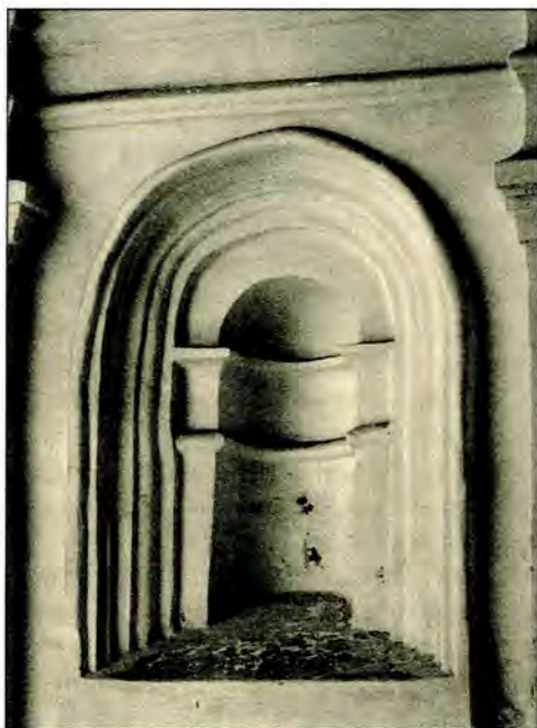
Північно-західний фасад. Ніша. Фото автора. 2004 р.
