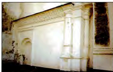
Келія XVII ст. біля північного фасаду пекарні. Східний фасад. Фото автора. 2002 р.
