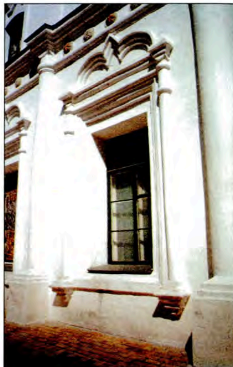
Друкарня. Західний фасад. Перший поверх. Фрагмент. Вікно. Фото автора. 2002 р.
