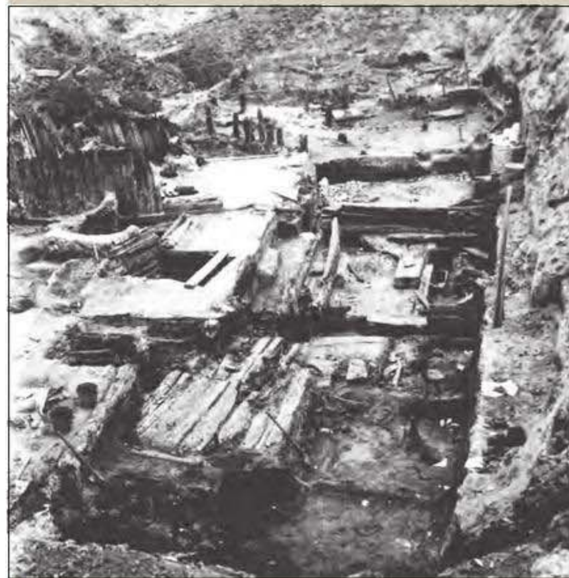
Дерев'яна забудова середньовічного Львова на місці будівництва готелю «Золотий лев». Площа Різні.
