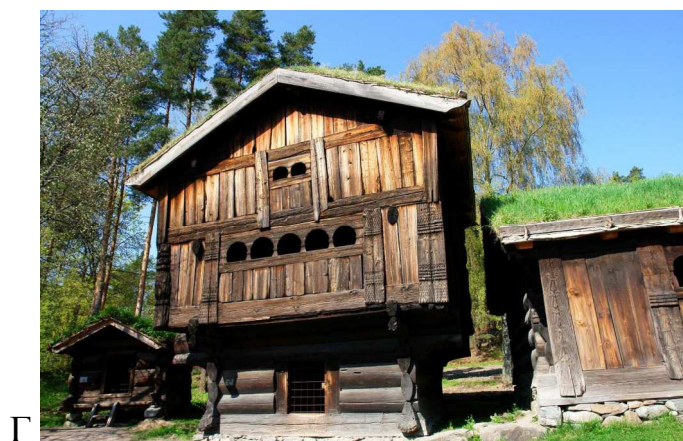
Рис. 3.6 Конструктивні варіанти змішування зрубу і каркасу в дерев'яному будівництві А – Поєднання в одну систему з розподіленням несучої та огорожуючої функції в норвезькій дерев'яній церкві (перевага каркасу, церква з с. Боргунд, XII ст., розріз за Й.Енсеніусом); Б – Використання зруб та каркас в різних частинах споруди в українських дерев'яних церквах (лемківська церква з с. Канора, XVIII ст., зараз в київському скансені, розріз за П. Макушенко); В – Норвезьке зрубне житло з верандою (хата з с. Кжеллеберг, скансен в Осло); Г – Норвезька каркасна комора (ферма з с. Сетесдал, скансен в Осло)
