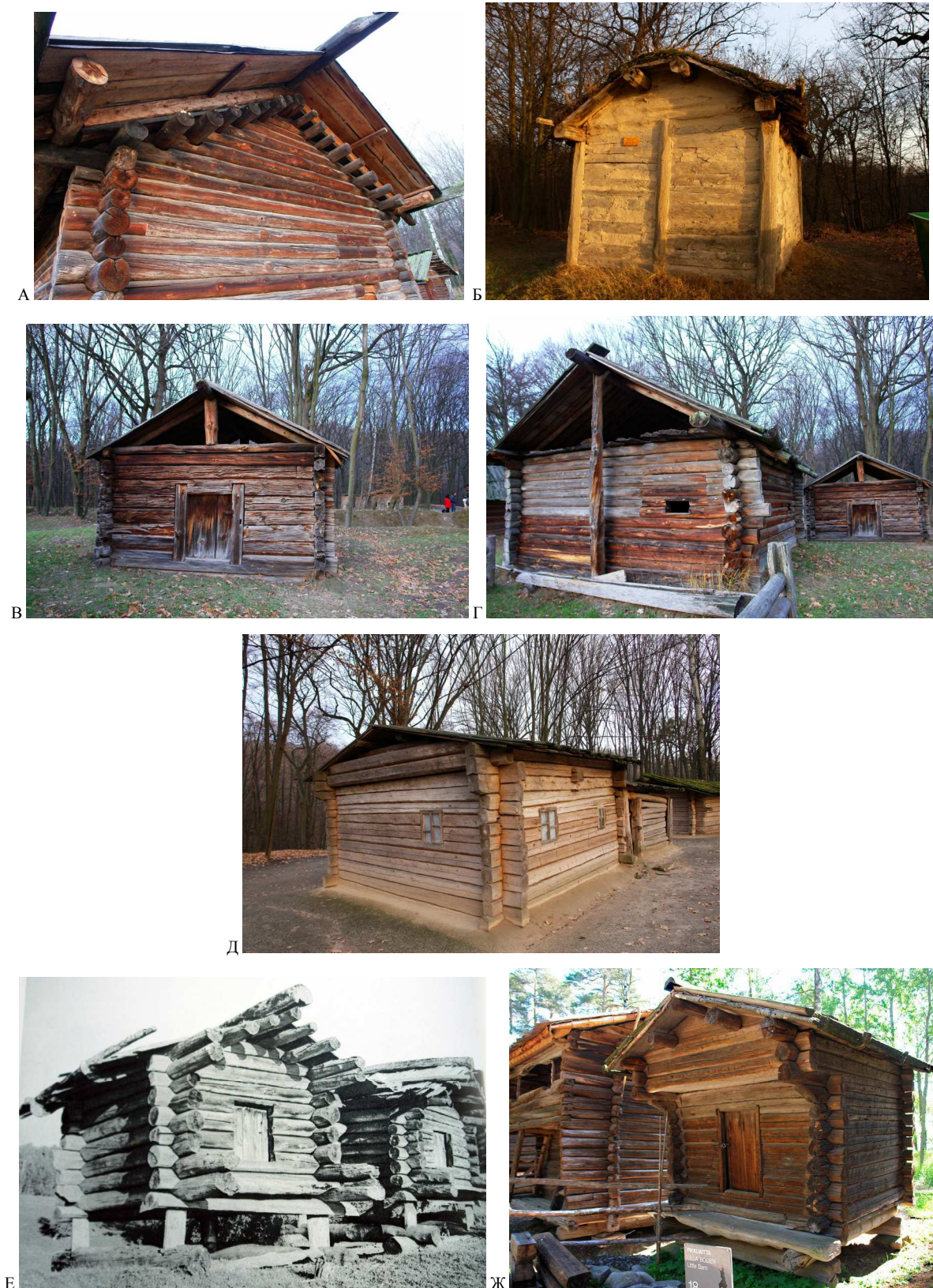
Рис. 3.9 Еволюція архаїчних перекриттів народних споруд А-Б – Господарчі споруди на фронтонах і сволоках, Рівненщина (Київський скансен); В-Г – Господарчі споруди з покрівлею на стовпах, Рівненщина (Київський скансен); Д – Архаїчне житло з відкритим горищем без опор, Рівненщина (Київський скансен); Іноземні комори з покрівлею на фронтонах і сволоках: Е – Село Хорніма, Архангельська область, Росія (за О. Ополовніковим); Ж – Фінляндія (скансен у Хельсінкі)
