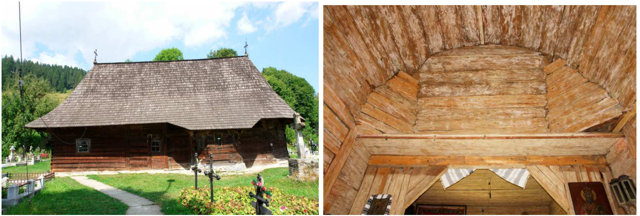
Рис. 4.8 Церква Драгос Вода з с. Путна, Румунська Буковина. Зовнішній вигляд з боку південного фасаду та рудименти зрубної конструкції „восьмерик на четверику” в інтер’єрі церкви
