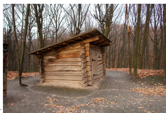
Рис. 3.8 Архаїчні способи перекриттів господарських споруд України А – Центрична зрубно-вінчата конструкція перекриття поліських клунь (за С. Таранушенко); Б – Кроквяна комора ХІХ ст. з с. Сухини Черкаської області (Київський скансен); Господарчі споруди із зрубно-накатним перекриттям: В – Стебка з села Нетреба, Рівненщина (XX ст.); Г – Хлівчук початку XX ст. з села Грабунь, Рівненщина (Київський скансен)
