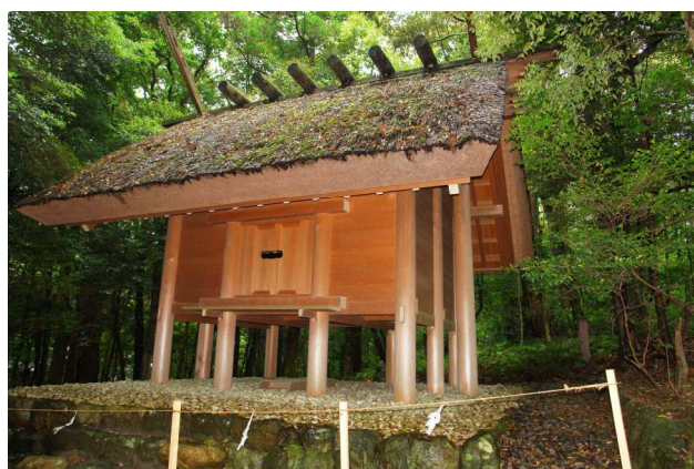
Рис 3.12. Імператорський храм в м. Ісе. Найку А – Головне святилище; Б – План змінних ділянок (за Т. Сакураї); В-Г – «Тігі» та «кацуогі» в покрівельній конструкції храму в м. Ісе (В – Головне святилище Найку (за Т. Сакураї); Г – Допоміжне святилище ідентичної форми)
